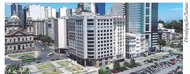
Prédio da Cápsula - Centro de Inovação Senac-RJ, no Centro do Rio
